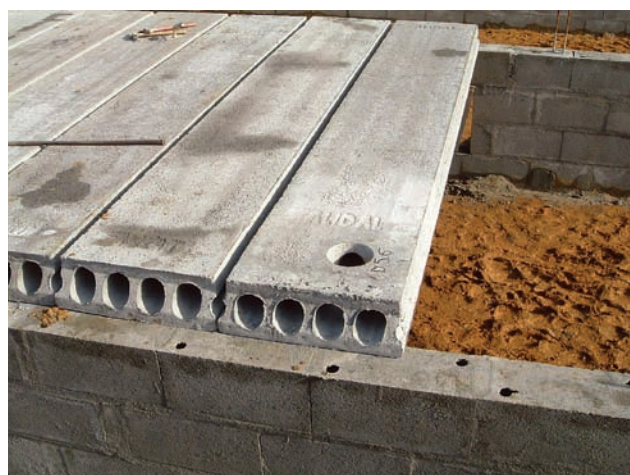
Nejmenší uložení panelů je 7 cm na zdivu z betonu a 15 cm na zdivu z cihelných a párobetonových bloků
