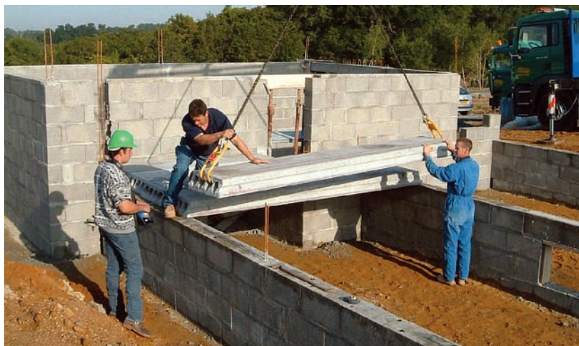
Předností panelů je nízká hmotnost a tím snadná doprava a ukládání hydraulickou rukou na připravené zdivo
